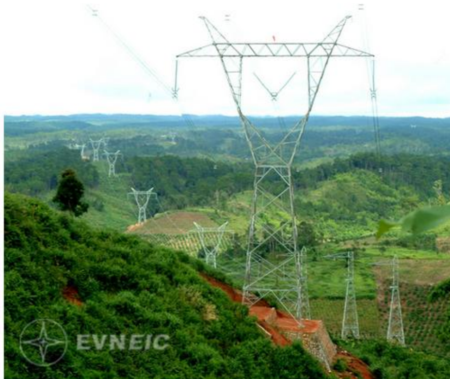
Hình ảnh: Đường dây 500 kV Bắc - Nam mạch 2
